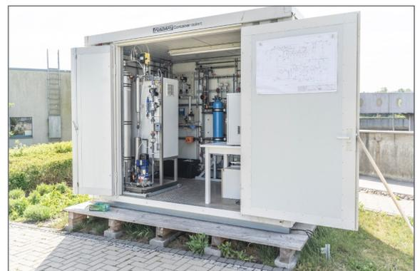
Transportable Anlage zur Abwasser-Behandlung mit integriertem Analysensystem ANTHROPLAS
